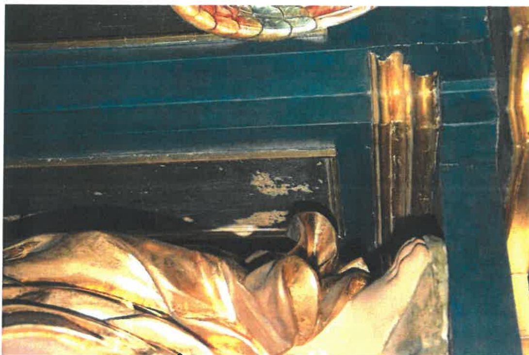
Fot. 26 kościół parafialny pw. Znalezienia Krzyża Świętego, w Łazanach. Elementy wystroju i wyposażenia wnętrza. Ołtarz kaplicy bocznej. Ubytki warszwy malarskiej widoczne na powierzchni prawej strony ołtarza.
