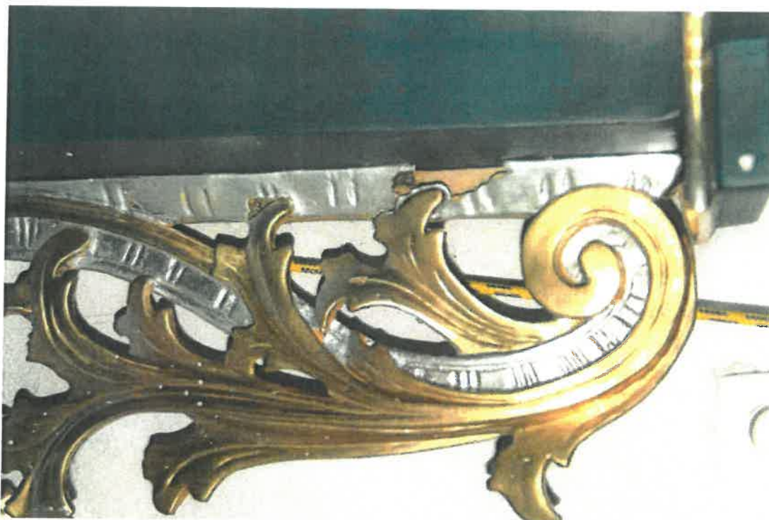
Fot. 7 kościół parafialny pw. Znalezienia Krzyża Świętego, w Łazanach. Elementy wystroju i wyposażenia wnętrza. Lewy ołtarz boczny. Zniszczenia warstwy zaprawy w obrębie lewego uszaka.
