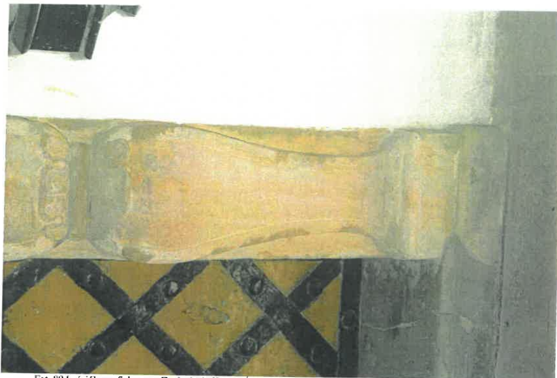
Fot. 89 kościół parafialny pw. Znalezienia Krzyża Świętego, w Łazanach. Elementy wystroju i wyposażenia wnętrza. Portal kamienny wejścia do kościoła z kruchty wejścia bocznego. Prawy węgar z widocznymi wcześniejszymi uzupełnieniami ubytków.
