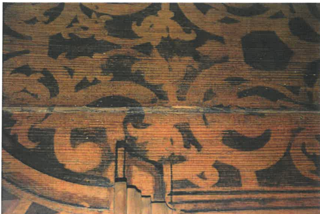
Fot. 44 kościół parafialny pw. Znalezienia Krzyża Świętego, w Łazanach. Elementy wystroju i wyposażenia wnętrza. Stalle. Uzupelnienie szczeliny zaplecka i scalenie kolorystyczne ornamentu, pochodzące z poprzedniej konserwacji.
