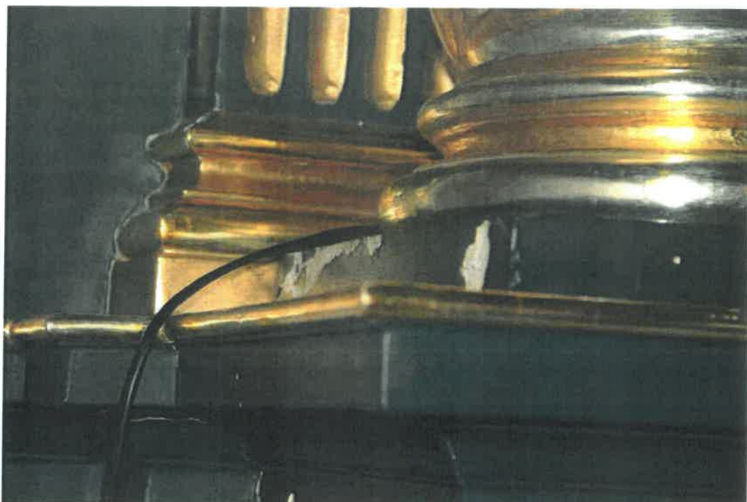
Fot. 11 kościół parafialny pw. Znalezienia Krzyża Świętego, w Łazanach. Elementy wystroju i wyposażenia wnętrza. Lewy ołtarz boczny. Uszkodzenia warstwy zaprawy, na bazie jednej z kolumn.
