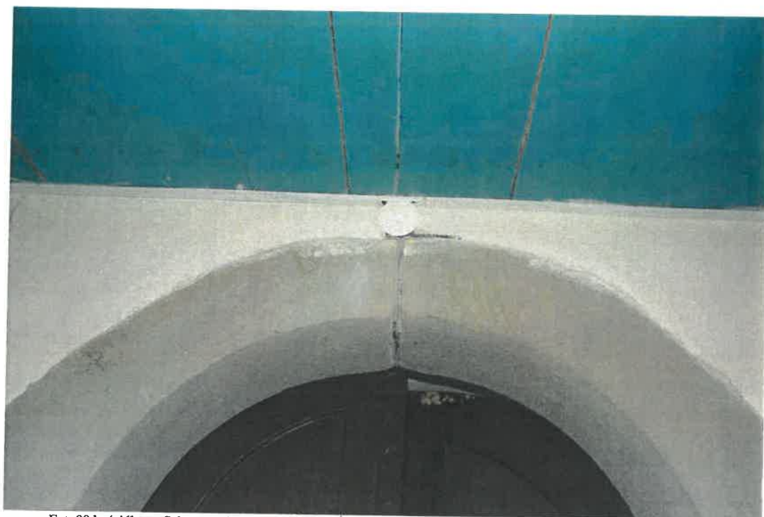
Fot. 90 kościół parafialny pw. Znalezienia Krzyża Świętego, w Łazanach. Elementy wystroju i wyposażenia wnętrza. Portal kamienny kruchty, wejścia głównego do kościoła. Górna część portalu z widocznym kablem poprowadzonym w spoinie.
