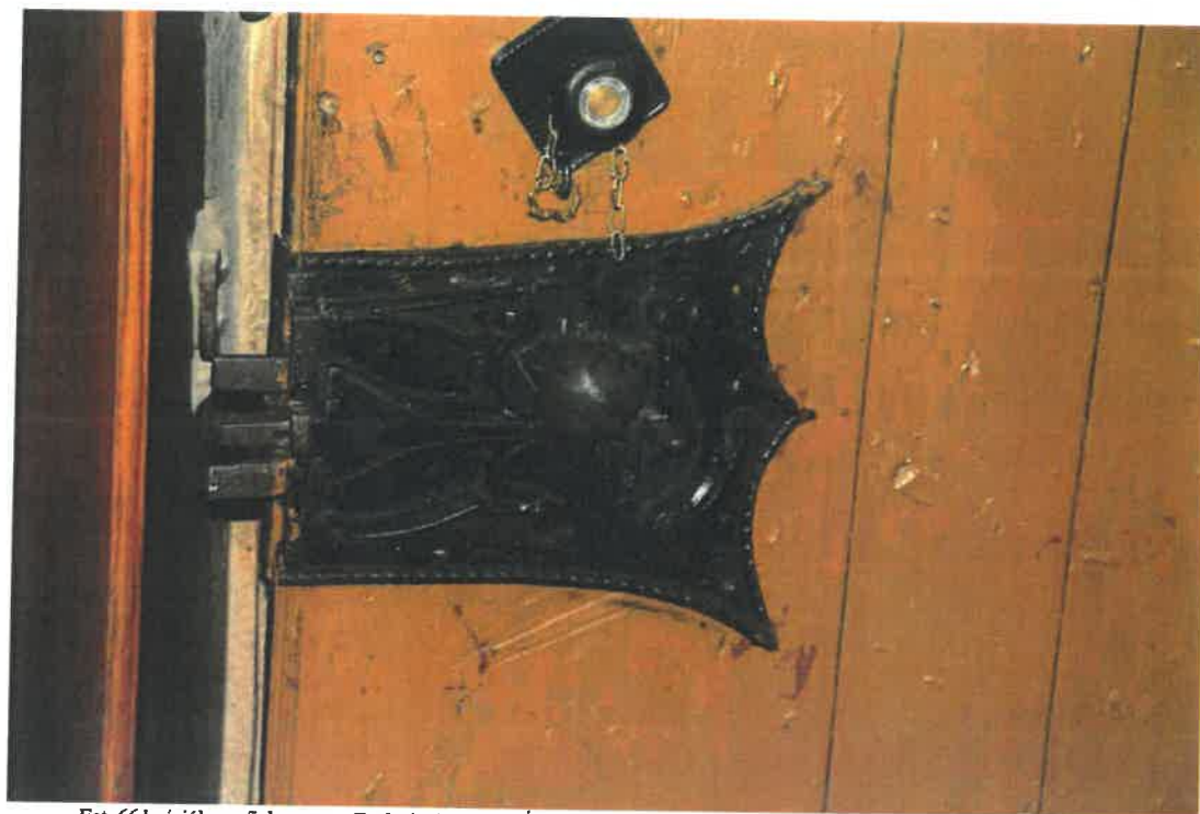
Fot. 66 kościół parafialny pw. Znalezienia Krzyża Świętego, w Łazanach. Elementy wystroju i wyposażenia wnętrza. Drzwi okute do zakrystii. Zamek drzwi.
